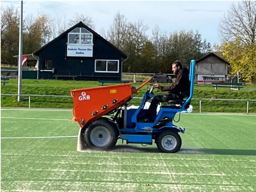
Der neue Rasen ist „ausgerollt“, die Linierung ist eingearbeitet und zum Schluss wird die Sandfüllung eingebaut.
